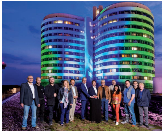
Auf dem Flachdach am Ostturm machen sich der UKM-Vorstand und das Dekanat der Medizinischen Fakultät ein Bild von der Fassadenillumination zur „Langen Nacht“. Dekan Prof. Mathias Herrmann, Ärztlicher Direktor Prof. Robert Nitsch und Kaufmännischer Direktor Dr. Christoph Hoppenheit (Mitte, v. r.) drücken nach bestandem Techniktest den Buzzer.
